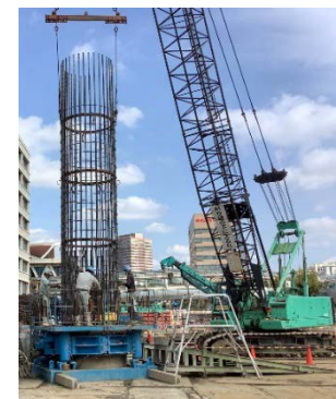
鉄筋かご挿入の様子
