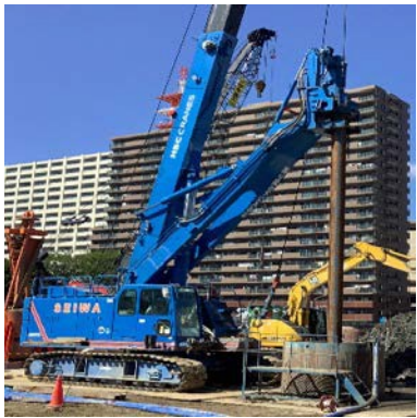
アースドリル杭打機
