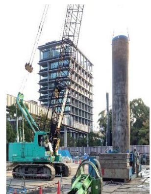
ケーシング建込みの様子
